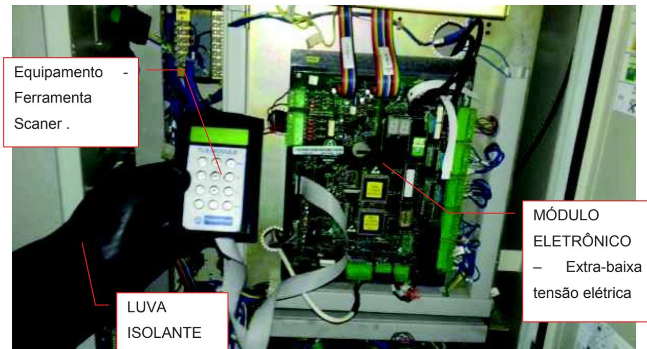
Na figura anterior mostramos uma operação elementar de análise de defeitos em elevadores, que utiliza uma ferramenta do tipo scanner, plugada em circuito eletrônico alimentado por extra-baixa tensão elétrica. Ressaltamos que, para evitar a possibilidade de contato acidental com partes energizadas é utilizada a LUVA ISOLANTE ELÉTRICA.
