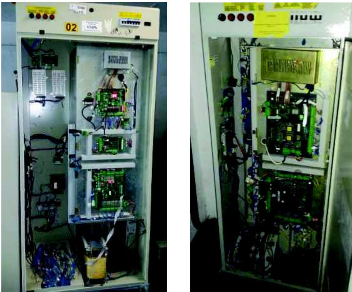
O quadro de comando do elevador possui dispositivos eletrônicos, elétricos, fiações e conexões, montados no interior de um armário metálico fechado, possuindo proteção e isolamento dos seus componentes. O quadro de comando dos elevadores é projetado e fabricado atendendo as requisitos das normas técnicas brasileiras, neste caso a ABNT NM-207.
