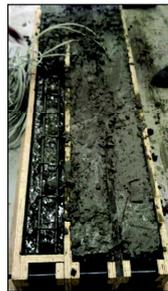
Figura 13.7 - Finalizar o preenchimento das formas, repetindo o processo de vibração e alisar a superfície à mostra
