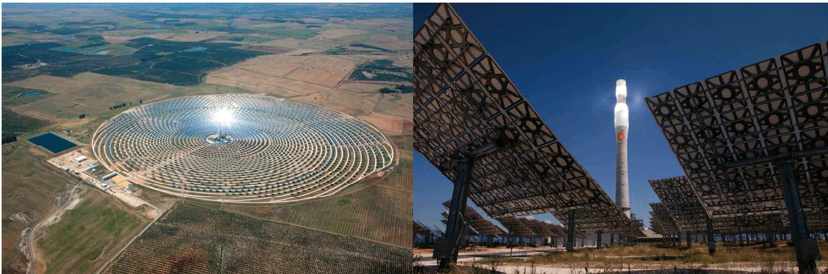
Figura 2.10 – Gemasolar: a maior planta de potência por concentração solar térmica do mundo, cuja potência instalada é de 19,9MW, localizada na Espanha
