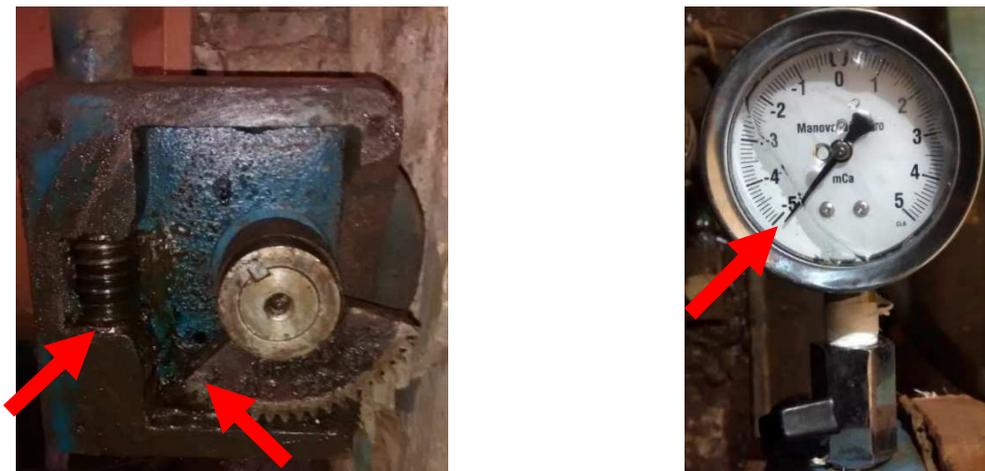
Apenas com uma ação, sem investimento, de conserto da válvula de sucção danificada, foi possível aumentar a vazão instantânea de, aproximadamente, 1.261,00 L/s para 1.352,00 L/s, quando do sequenciamento entre os grupos 01, 02 e 03 em paralelo. Não foi quantificado o ganho energético/financeiro dessa atividade de manutenção, em função de não se ter dados
