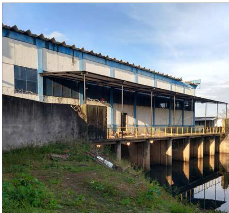
Figura 02 – Casa de bombas da Santo Afonso
